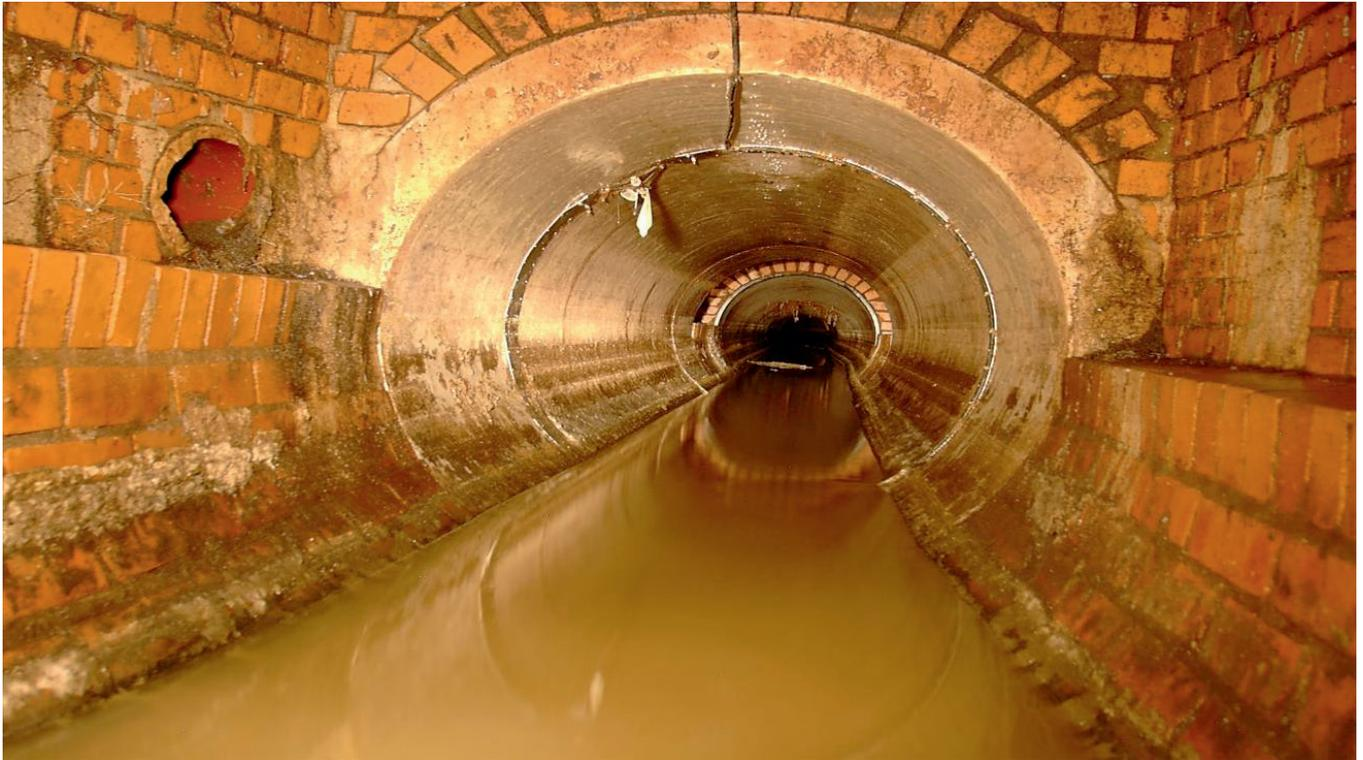
Abb. 11: Blick in die unterirdische Mischwasserkanalisation (Stadtentwässerung Elmshorn)
